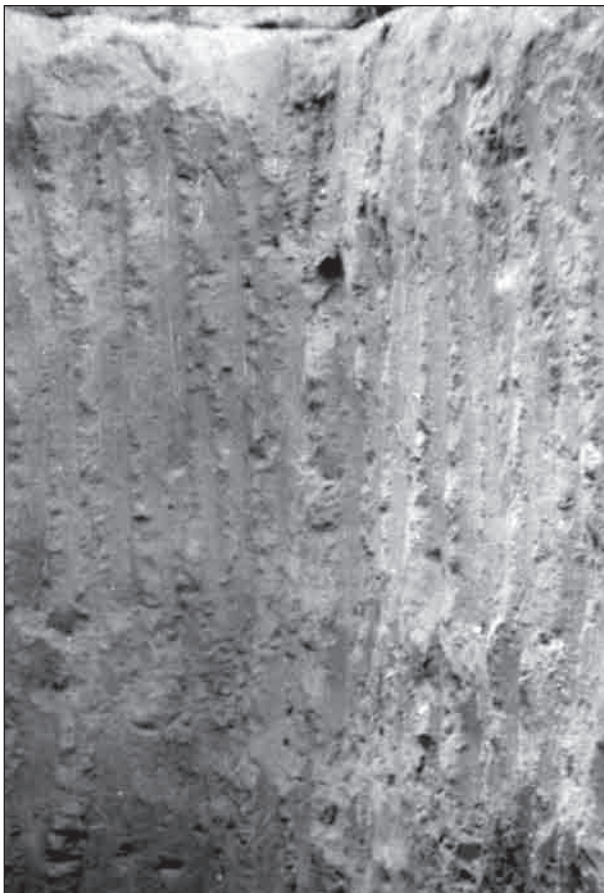
Рис. 5. Сліди теплоподібного знаряддя на стінках споруди
