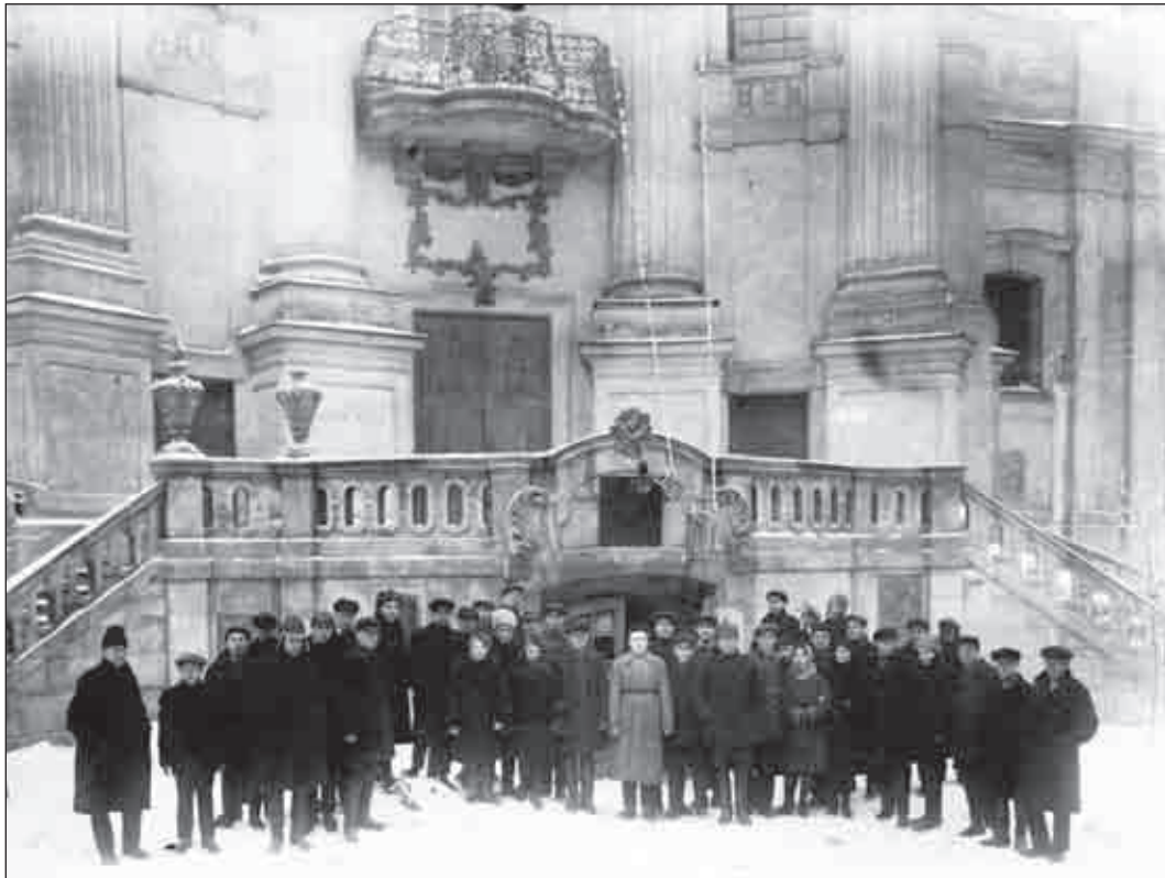
Рис. 15. Т. М. Мовчанівський (п'ятий зліва) з групою екскурсантів біля входу до нижнього костелу монастиря «Босих Кармелітів» [Фото з сайту «Мій Бердичів»: http://berdychiv.in.ua/wp-content/uploads/1925_muzey.jpg ]
